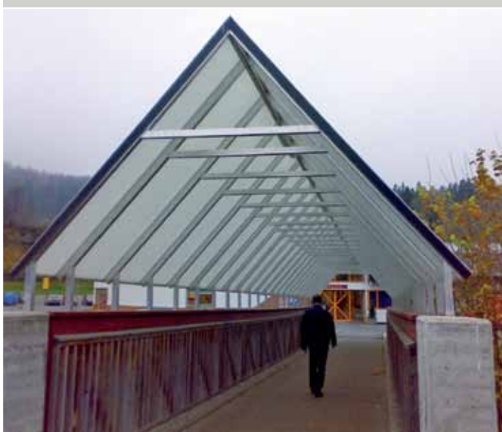
Rytterlys som tak over gangbro, Rortunet, Slemmestad
