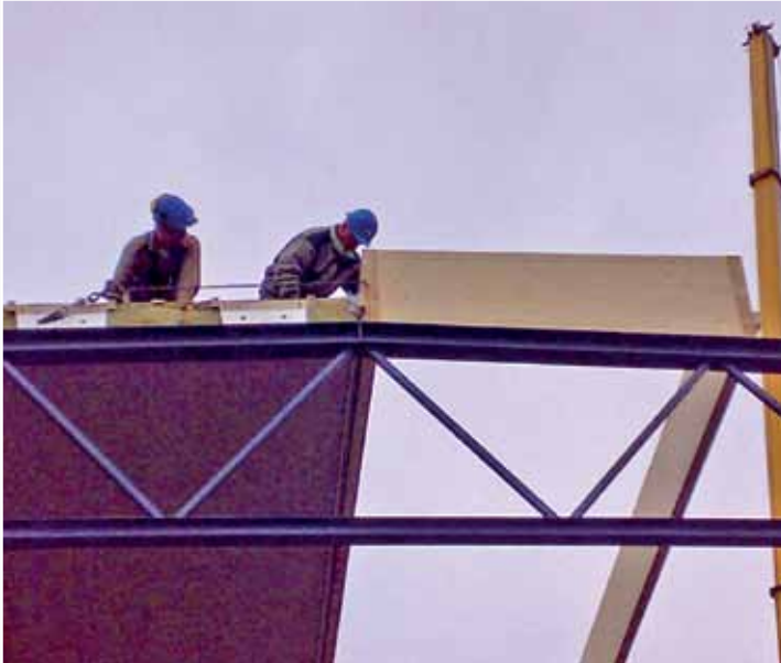
Montering av limtrekarm
