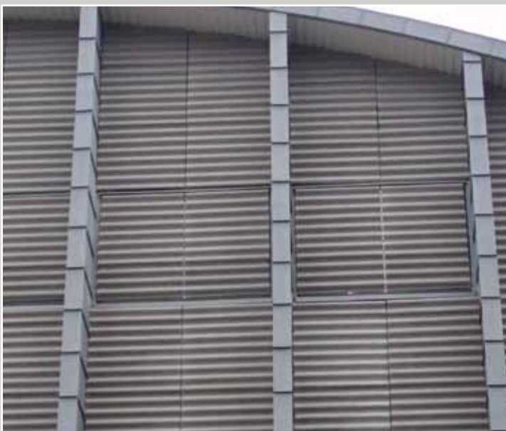
Røykluker i fasadevegg, Skien idrettshall
